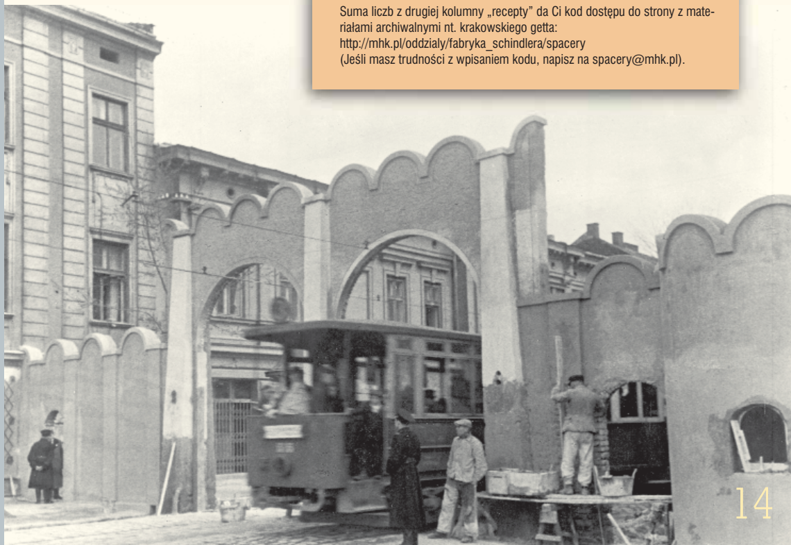
Brama nr 1 przy Rynku Podgórskim podczas budowy, kwiecień 1941, fot. ze zbiorów Bundesarchiv
